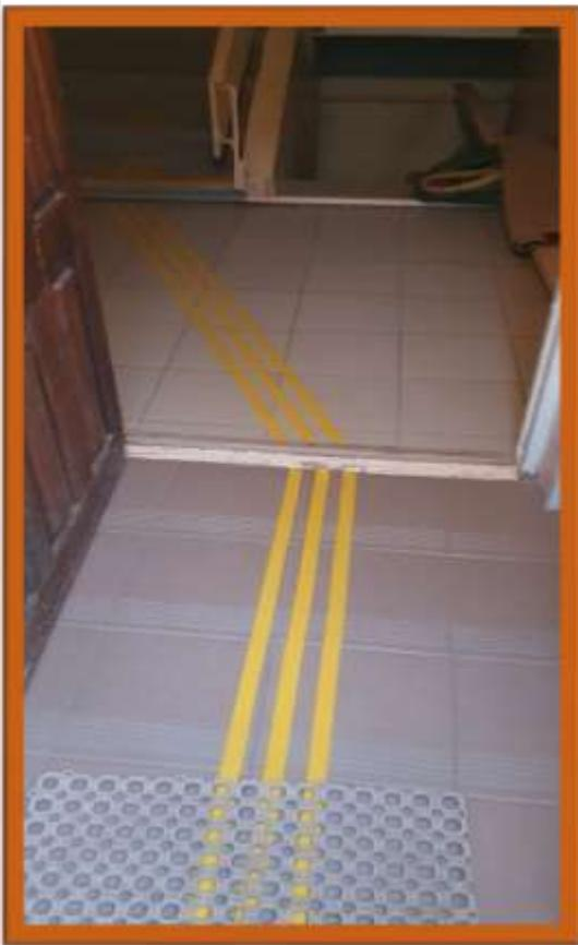
**Напольная тактильная лента – специальное контрастное устройство для инвалидов, предназначенное для определения «опасных зон» и ограничений безопасного пути незрячего человека и с остаточным зрением**
